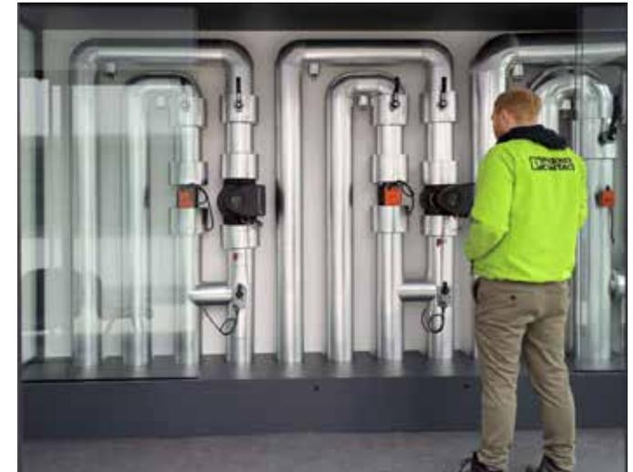
Abbildung 4: Drei Ventilboxen steuern die gesamte Wasserzufuhr auf 3500 m PE-Rohr
